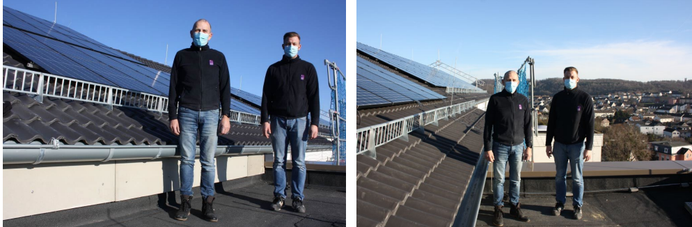
v.l.: Peter Ellinghaus (Stellvertretender Technischer Leiter) und Thorsten Lisdau (Werkstattleiter) inspizieren die neue Photovoltaik-Anlage auf dem Dach des historischen Haupthauses der Lungenklinik Hemer mit tollem Blick über die Stadt Hemer (Foto: Anja Haak, Lungenklinik Hemer)
